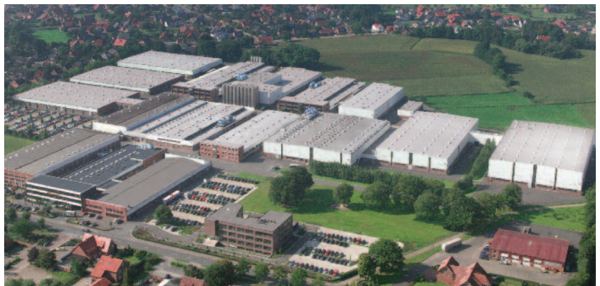
Germany, Plant I: Pöppelmann GmbH & Co. KG, Kunststoffwerk-Werkzeugbau, Lohne.
