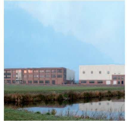
Germany, Plant III: Pöppelmann GmbH & Co. KG, Lohne
