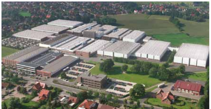
Deutschland, Werk I: Pöppelmann GmbH & Co. KG, Kunststoffwerk-Werkzeugbau, Lohne.
